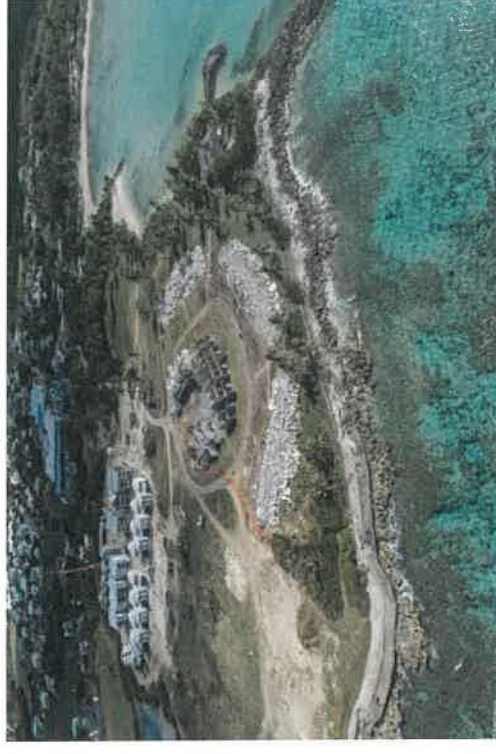
La presqu'île de la baie du Moule aujourd'hui... Travaux en cours
